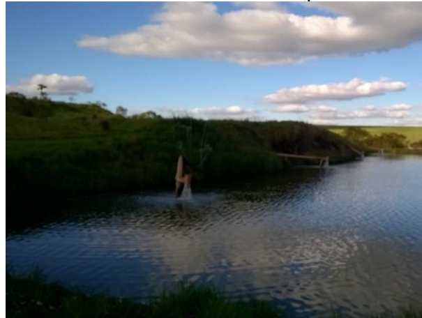
Figura 2. Vista da região de entrada da primeira lagoa facultativa com suas estruturas de alimentação.
