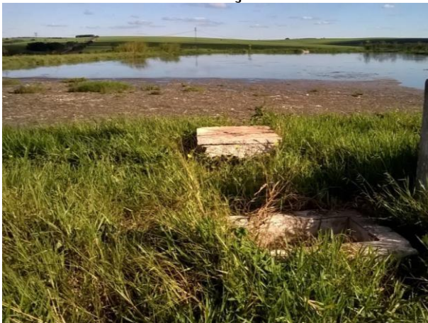
Figura 1 Vista da região de entrada da lagoa anaeróbica com sua caixa de alimentação.
