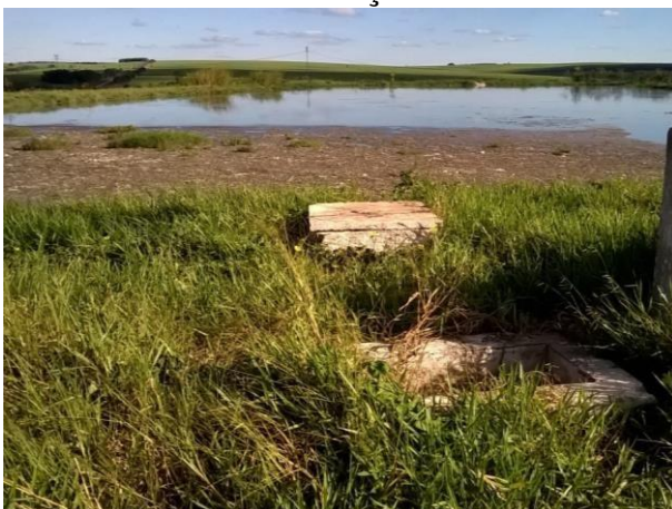
Figura 1 Vista da região de entrada da lagoa anaeróbia com sua caixa de alimentação.
