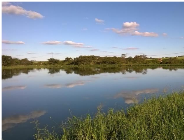
Figura 3. Vista global da segunda lagoa facultativa. Ao fundo observam-se as estruturas de coleta de efluente.
