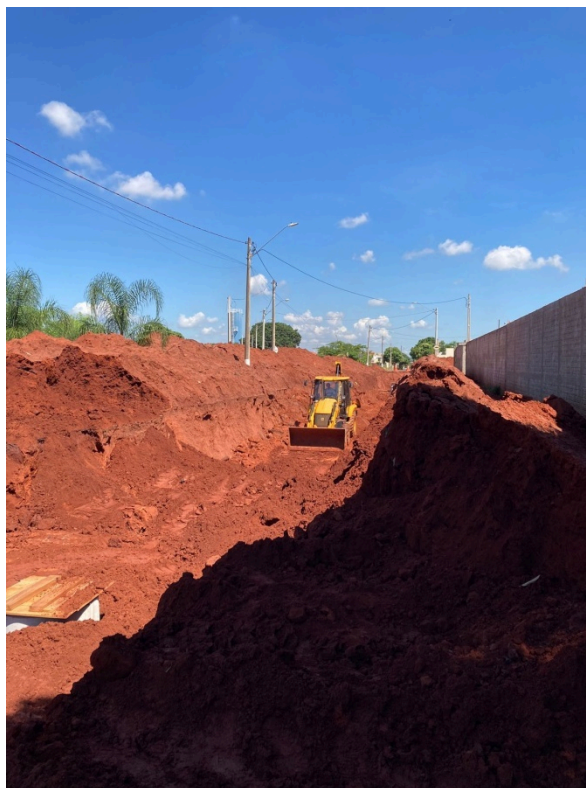
Figura 05 – Intervenção após a quebra da rede de abastecimento.
