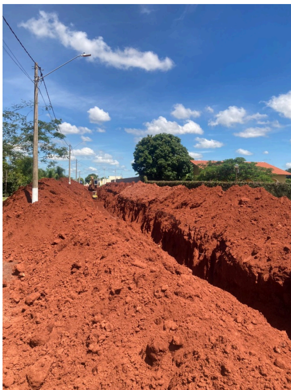
Figura 02 – Intervenção para reconstruir a rede coletora esgoto. A imagem mostra uma grande vala escavada na rua, com terra vermelha e pedras expostas. Um poste de luz está visível no fundo, e o céu é azul com algumas nuvens.
