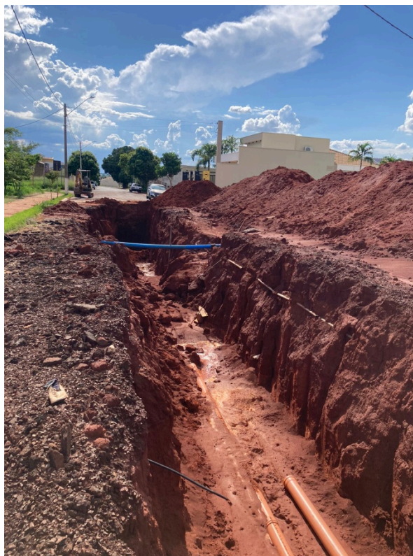
Figura 07 – Intervenção na rede de esgoto.
