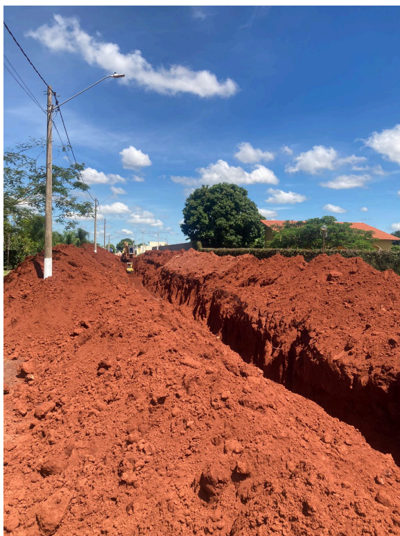
Figura 02 – Intervenção para reconstruir a rede coletora esgoto.
