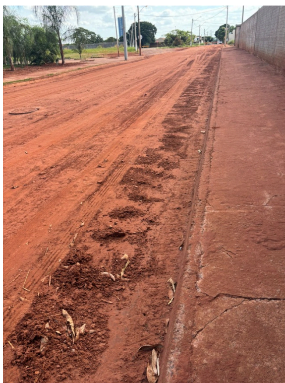
Figura 10 – Finalização da Intervenção na rede de esgoto.
