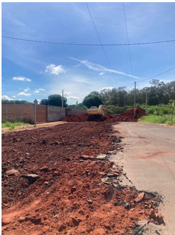
Figura 01 – Início da intervenção para reconstruir a rede coletora esgoto.
