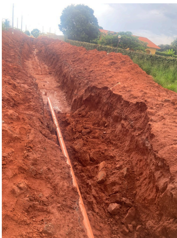
Figura 06 – Intervenção na rede de esgoto.
