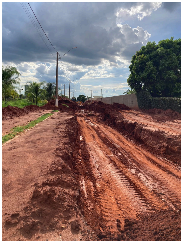
Figura 08 – Intervenção na rede de esgoto.
