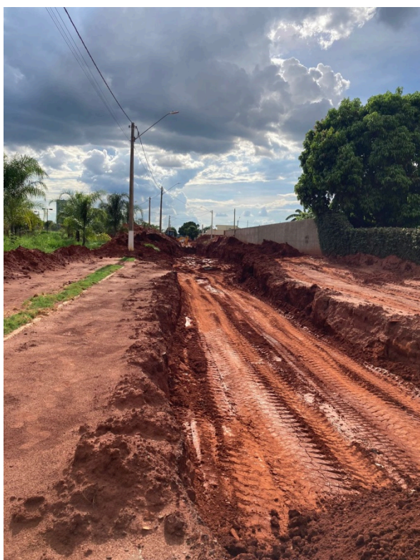
Figura 08 – Intervenção na rede de esgoto.
