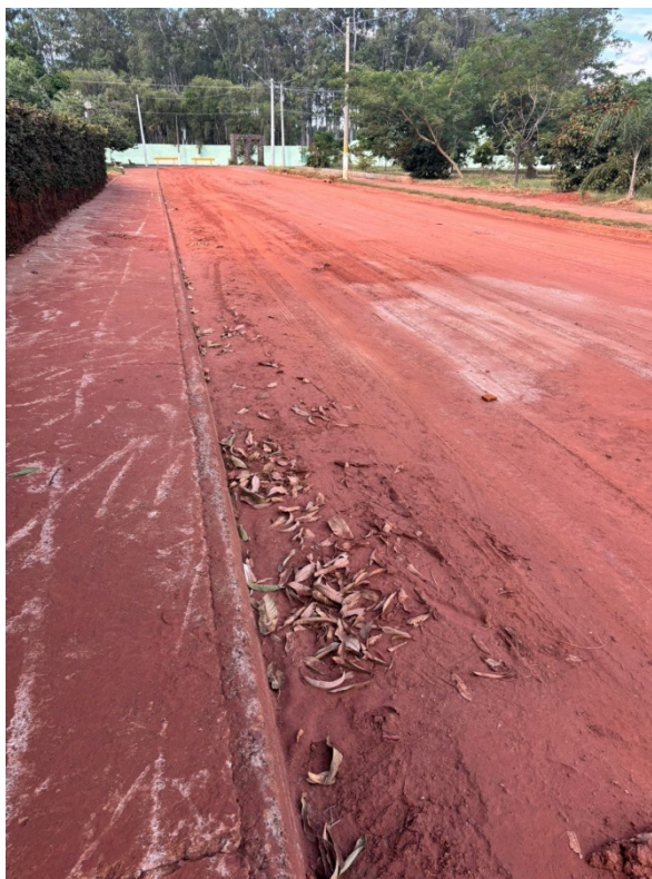
Figura 09 – Finalização da Intervenção na rede de esgoto.
