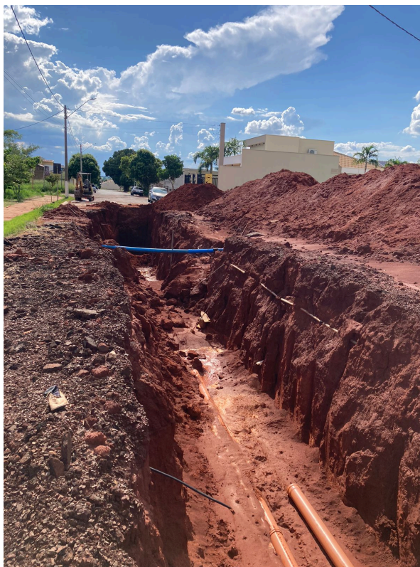
Figura 07 – Intervenção na rede de esgoto.
